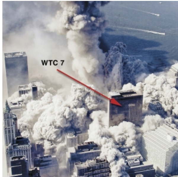
Foto: WTC 7 antes de su demolición después de que se desplomasen las torres.
