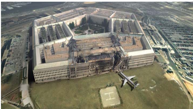
Foto: reconstrucción a escala tras el derrumbe del techo.
